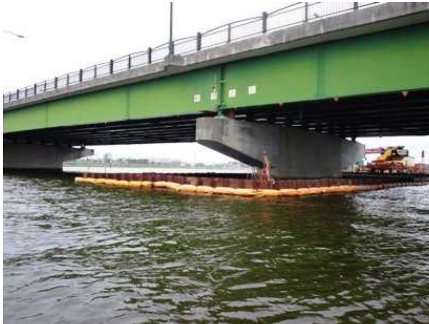
橋脚補強工事
